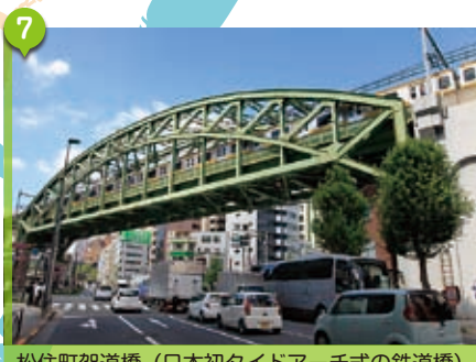
松住町架道橋 (日本初タイドアーチ式の鉄道橋)
