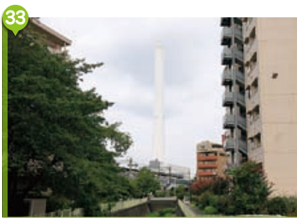
33 杉並清掃工場の煙突がランドマークに
