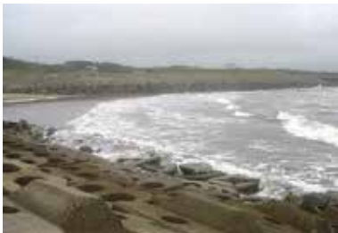
図4 礫養浜前の侵食された海岸
