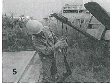
吊具、玉掛けワイヤーの点検
