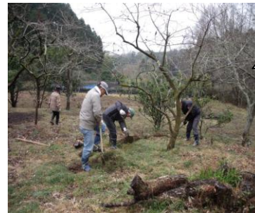
竹・笹の根が侵入しないよう溝掘り作業
