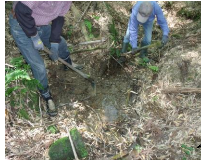
下田の水源地付近、蔓枝葉サバ土等に遮られ堰止められた水路の復元作業
