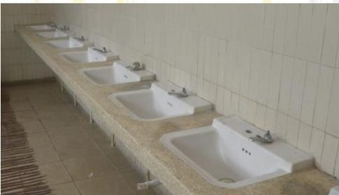
Durante del recorrido por las instalaciones, se constató que los sanitarios y lavabos recibieron mantenimiento y se repararon las fugas para su adecuado funcionamiento. El resto de los puntos descritos anteriormente aún persisten.
