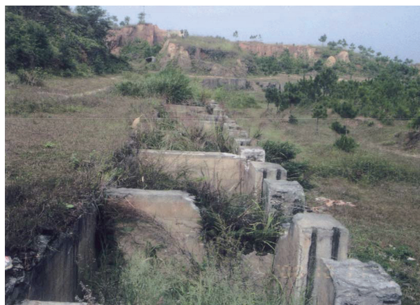
写真12. 風化粘土を酸リーチングしたコンクリート槽
