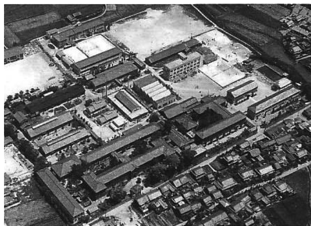
井巻さんが在学していたころの姫路工業大学。当時は姫路城の北、姫路市伊伝居地区にあった
