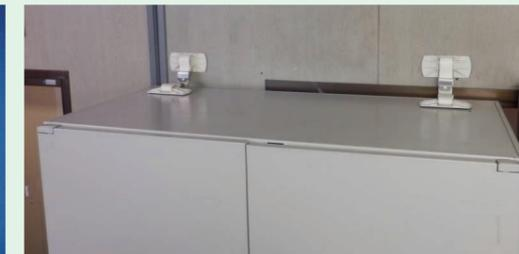
①天板・壁面の接着する部分をアルコールパッドにて清掃し、
