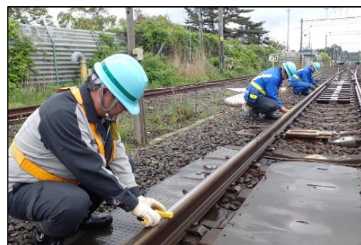
（図④）手検測による歪み測定
