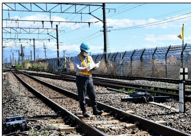
（図⑤）徒歩による線路点検や測定器でレールや継目板ボルトなどの状態を確認
