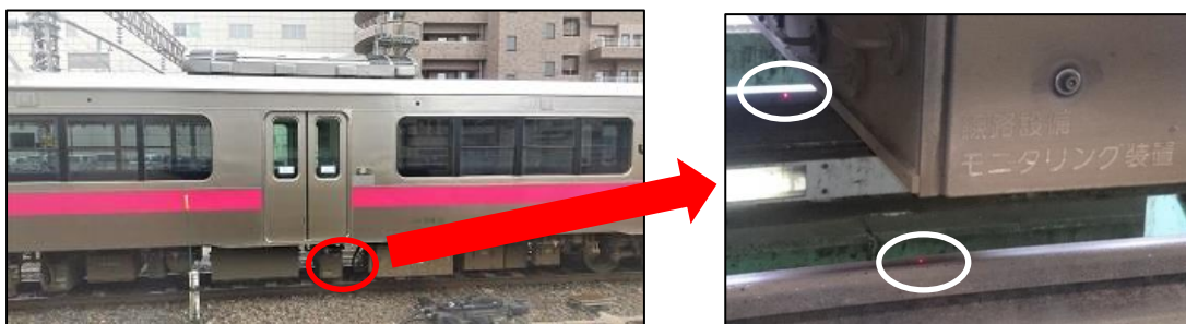
(図①) 軌道変位モニタリング装置
