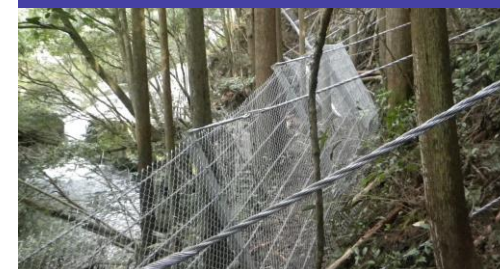
起伏に合わせて施工可能
