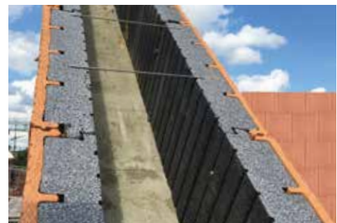
POROTON®-DS vario als Ringbalken. Montagebügel zur Lagesicherung bei der Montage und nicht als Schalungsbügel einsetzbar; Bedarf ca. 1 Stück/m, wiederverwendbar.
