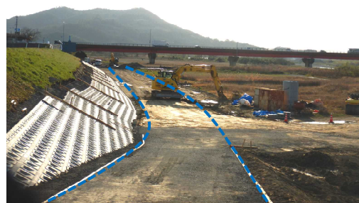
整備中の専用道路（紀の川市）
