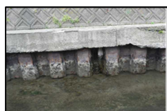
河川護岸（矢板護岸）
