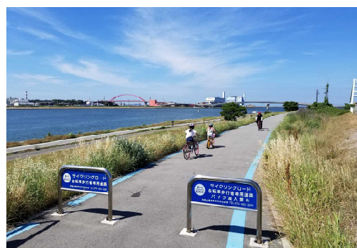
河川敷を利用した専用道路（和歌山市）
