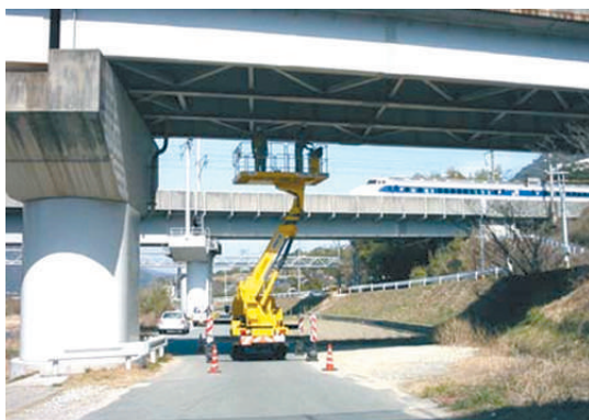
桁下からの橋梁点検
