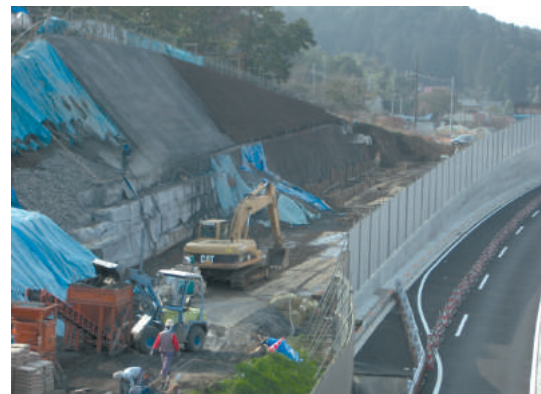
のり面崩壊現場の復旧工事風景 (八王子市新滝山街道下り線)
