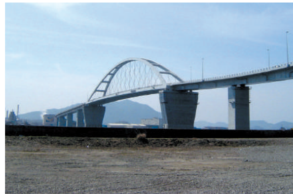
周南大橋（鋼二ールセンローゼ橋）
