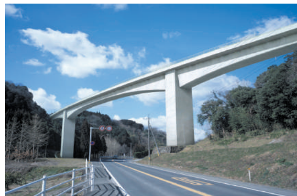
茜川橋（PC3径間連続ラーメン箱桁橋）
