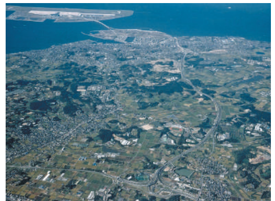
知多横断道路（セントレアライン）
