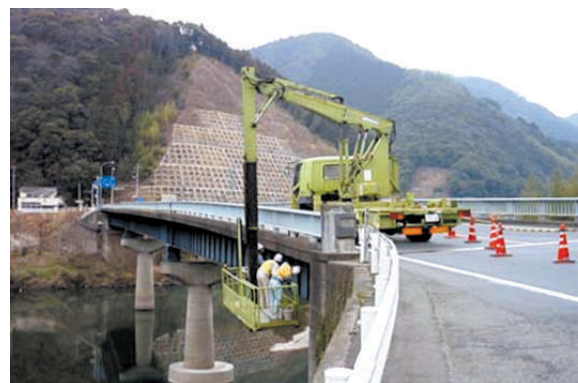
橋面からの橋梁点検
