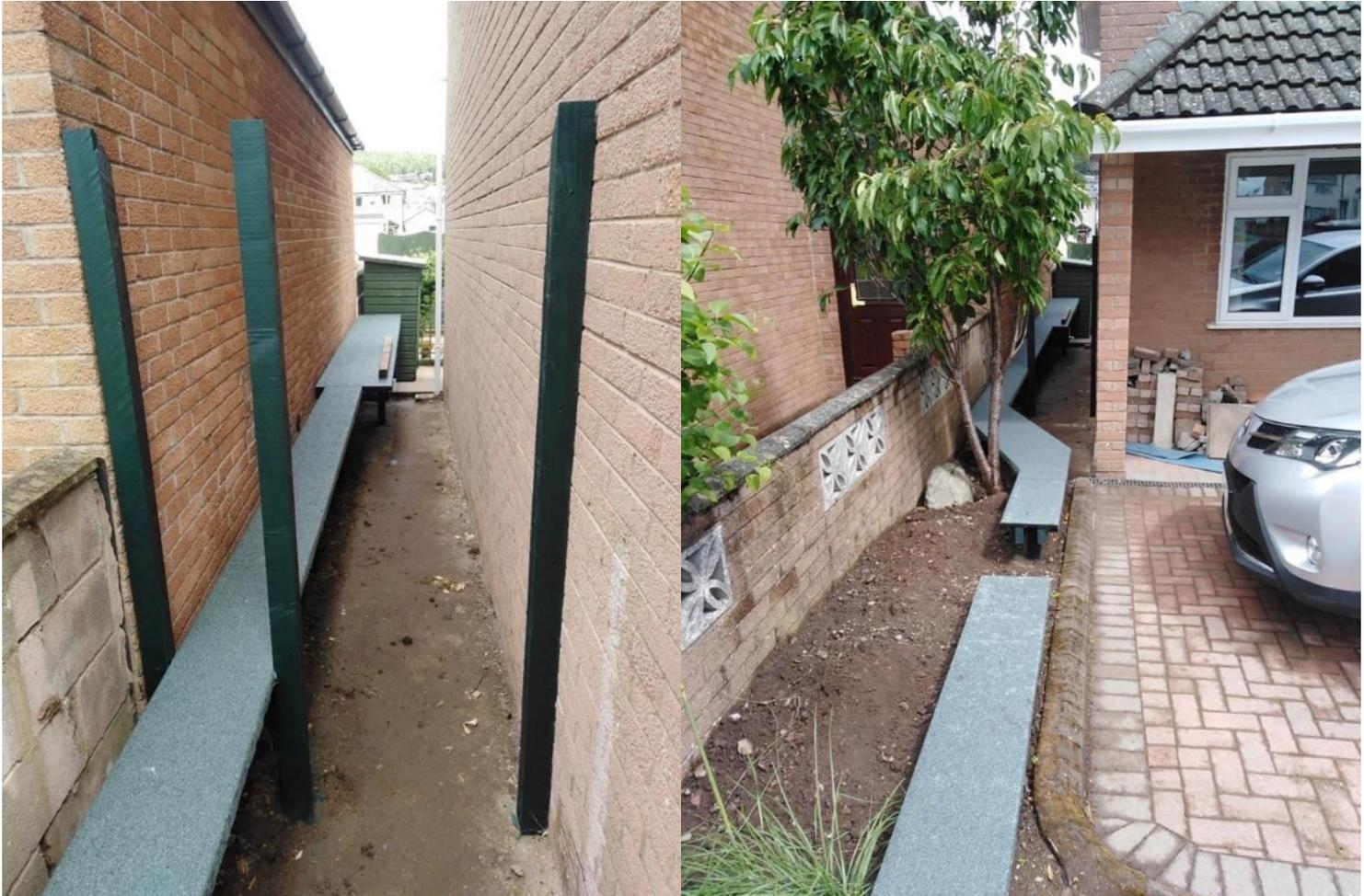
日本人だとこの道床に耐水塗料と塗装しますが、この方は耐水性の有る壁紙(サイディング)を道床に貼って手間を省いています。しかもバラスト柄の！敷地が玄関側が高く、庭側が低い傾斜地なので、玄関側は、地べたに、庭側に焚き上げや、牽引車両用の引き込みプラットホームを建設して、出入りの邪魔にならず、運転時腰を痛めない設計になっています。
