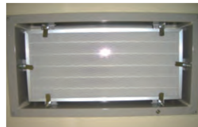
フィルタ設置
