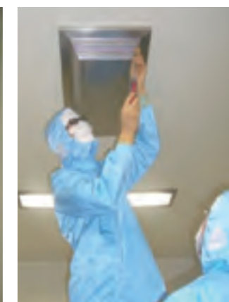
パンチング設置
