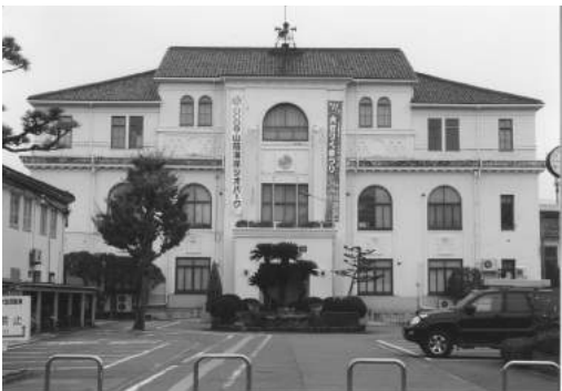
図11 豊岡町役場の変遷 A) 1927年の新築時（『豊岡復興誌』による）、B) 1960年頃のシビックセンター全景（『空から見た但馬』による）、C) 2012年の市役所（筆者撮影）
