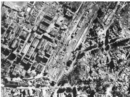
Bombardement de la ville allemande de Celle: Destructions matérielles
