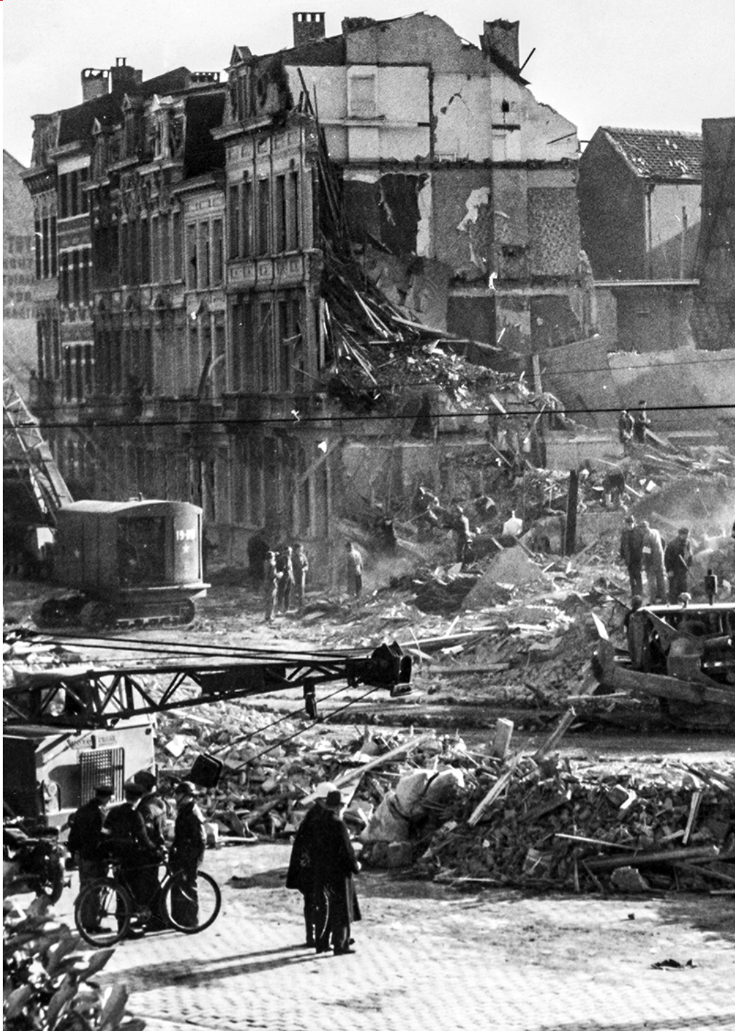
Impact du premier V1 sur le centre d'Anvers. Un bloc de 8 habitations est rasé. Les Américains déblaient les ruines, © WHI, Bruxelles.
