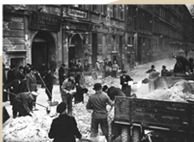
4. Déblaiement des débris
