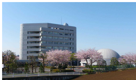
左建物 本館 右建物 プラネタリウム館
