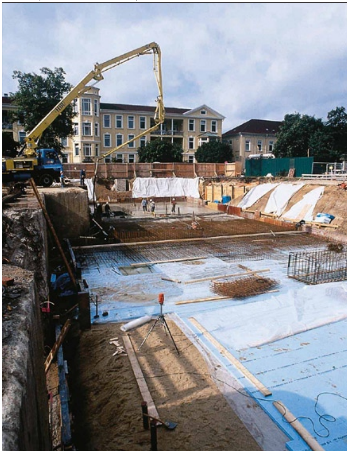
Рисунок 7.1 Производство работ по теплоизоляции STYROFOAM GEO
