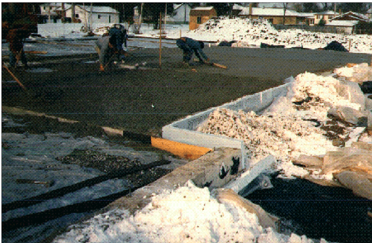
Рисунок 7.8 Укладка бетонной смеси
