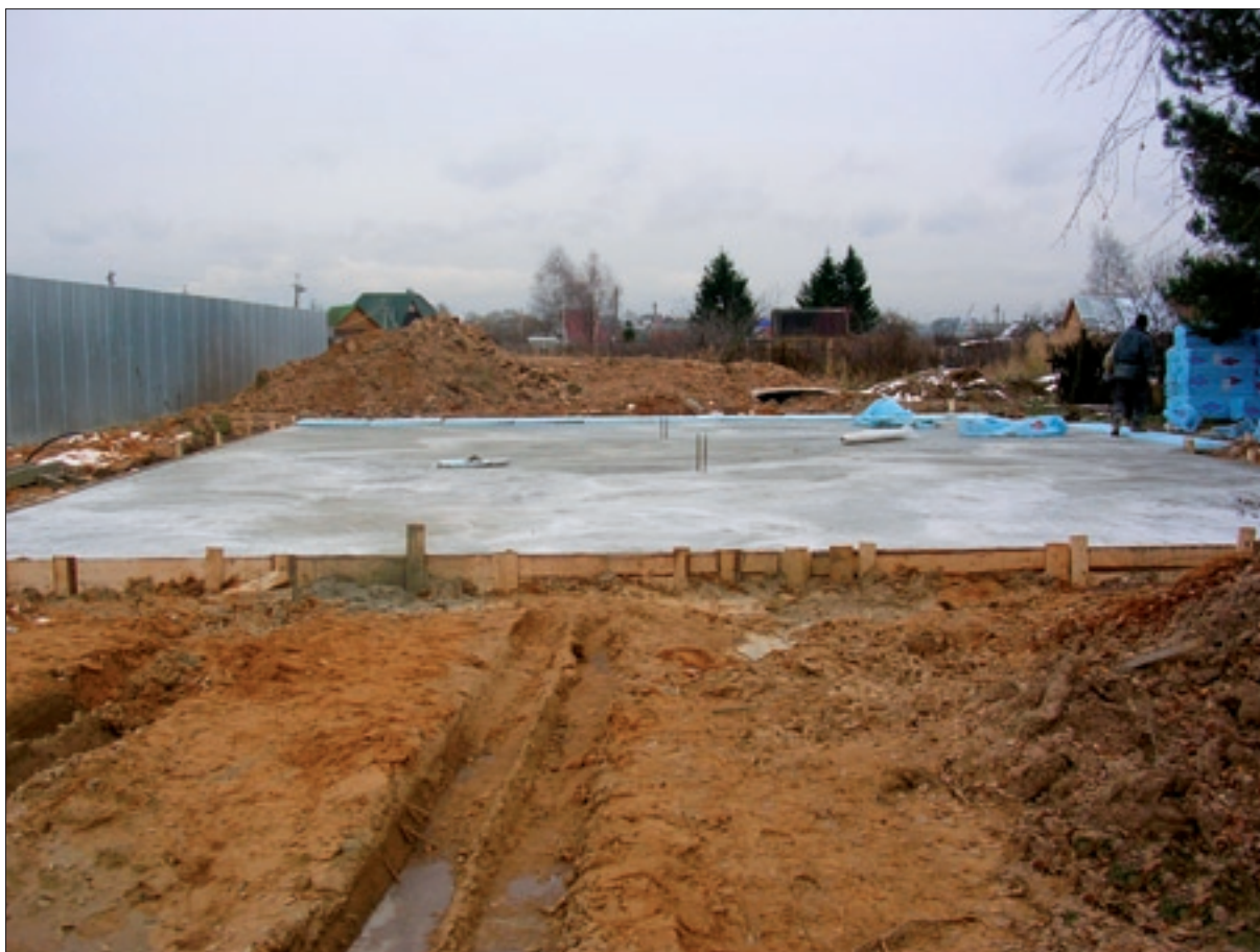
Рисунок 7.9 Уход за бетоном
