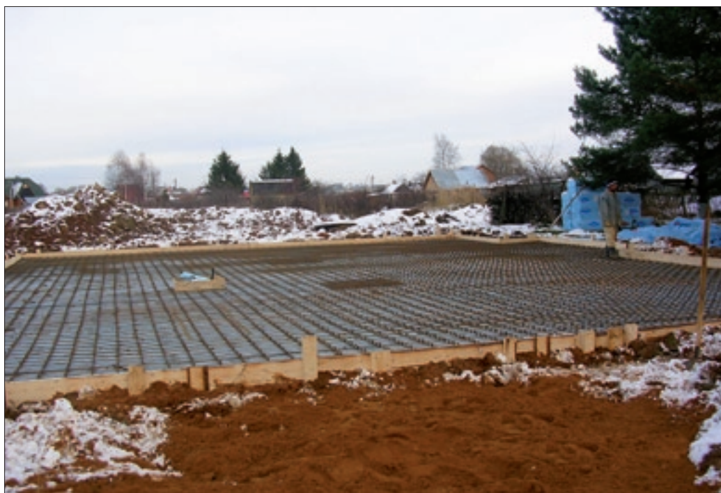
Рисунок 7.6 Монтаж арматуры по теплоизоляции STYROFOAM GEO
