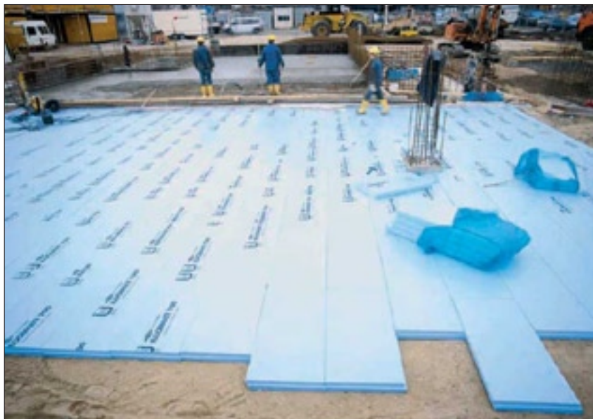
Рисунок 7.7 Укладка бетона по теплоизоляции STYROFOAM GEO
