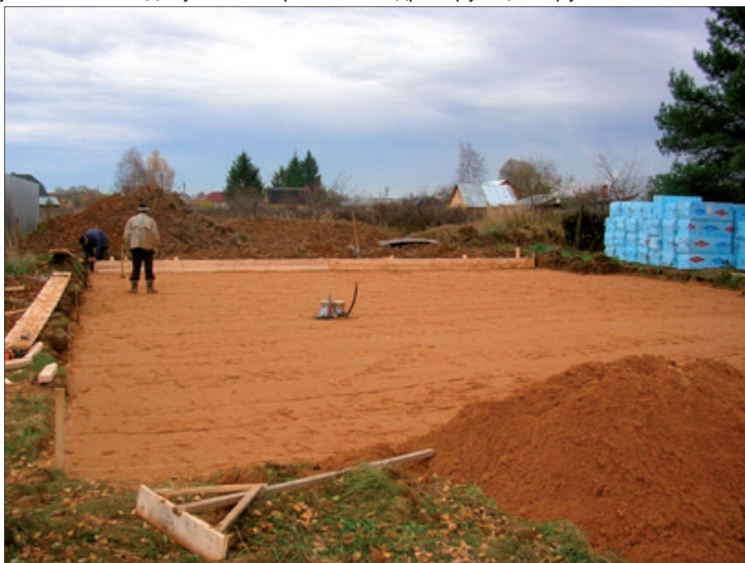
Рисунок 7.2 Уплотнение грунта до укладки теплоизоляции STYROFOAM GEO
