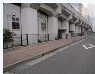
▲高架橋柱補強
