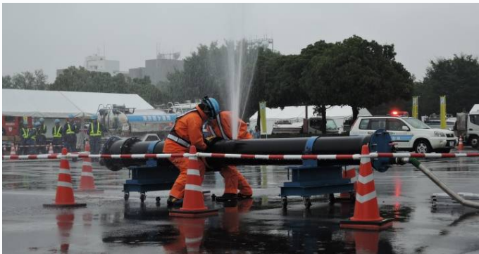
〈漏水を修繕する応急復旧訓練〉
