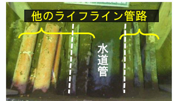
埋設物が輻輳している例
