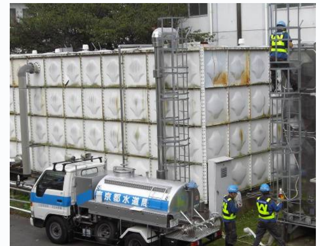
〈給水車から医療機関への応急給水〉
