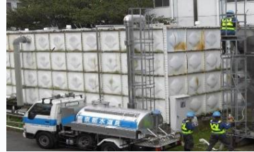
〈給水車による応急給水〉
