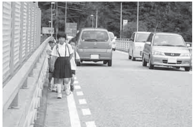
歩道橋工事が待ち望まれる川本大橋
