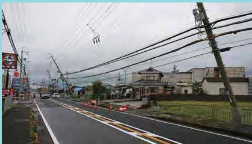
2018 年 台風 21 号による強風被害（電柱が折れる） （摂南大学池内淳子氏提供）
