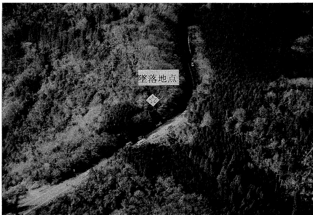
写真 1 - 1 事故現場 (空撮)
