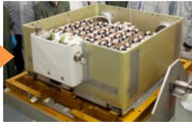
リチウムイオンセルのバッテリーへ組み込み
