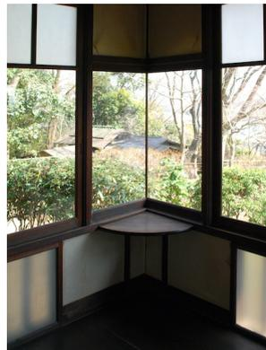
涼しく暮らすための工夫も見どころのひとつである。庭の木々や深い庇が夏の直射日光を遮る。また、気流・通風を考慮した通風口、床下の冷たい空気を内部を通し屋根裏へ排出させる天井排気口や、西側に設置された通気口から地中に埋め込んだ土管を通して外気を室内に送るクールチューブは天然のクーラーである。襖や障子、欄間を開けることで風が通り抜け、家は大きな一室となる(一屋一室)。断熱は様々な研究検討の上、土塗壁を採用している。仕上げは和紙を貼るなど、天然の調湿を考えた、まさに現在の無添加・パッシブ住宅である。
