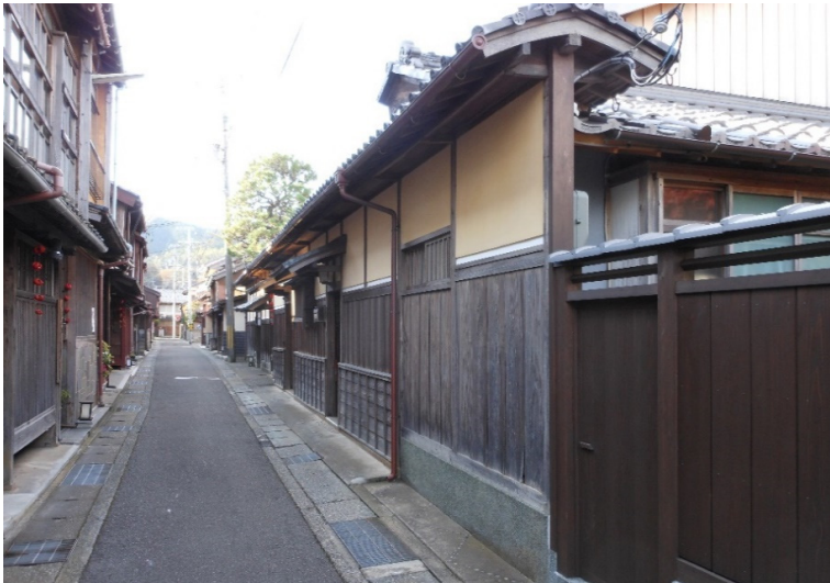
外観正面（三丁町通り北から）
