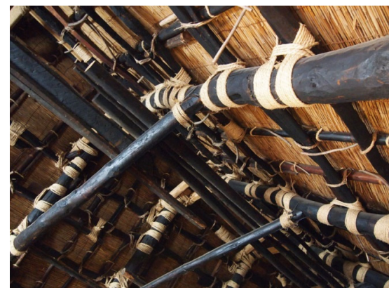
梁組は建築当時のままであるが、茅葺は更新され続け縄の結び方など技術の継承が見られる
