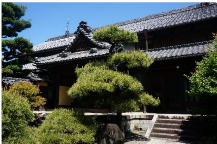
外観：式台玄関付近
