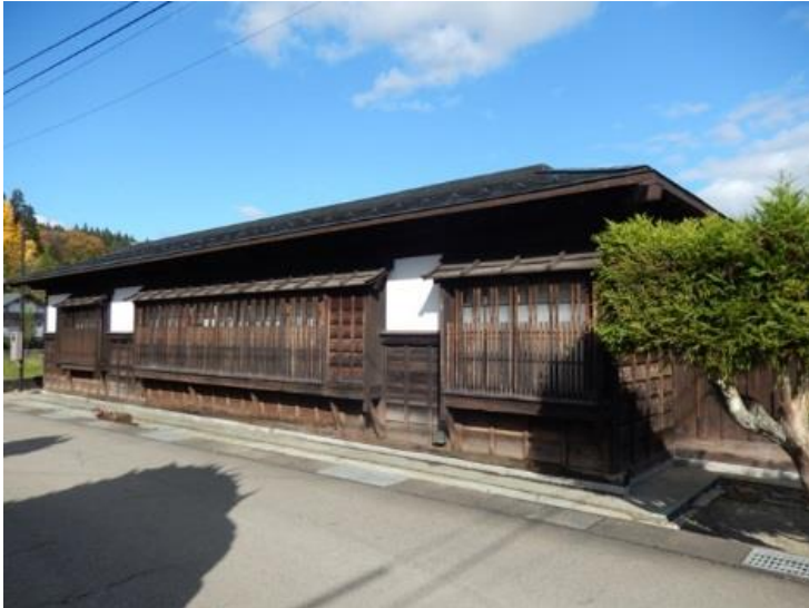
西側通り 座敷部
