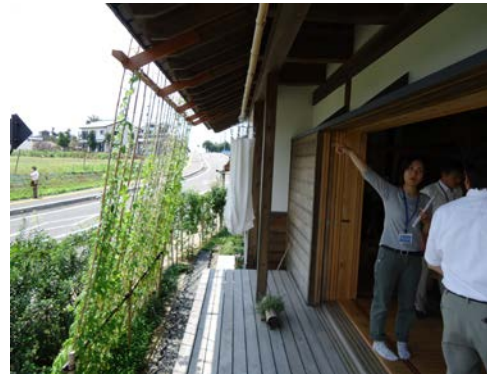
●（カーテン状の植栽）日射遮蔽のためのよしずの役割を担う、つる性植物による緑のカーテン（写真：⑦）
