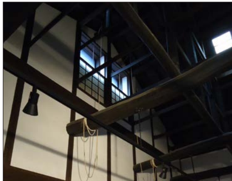
●（伝統的な民家） 町家の土間の採光と換気を確保する高窓と天窓
