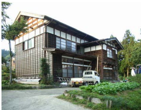
●（せがいつくり）軒を深くだすための伝統的な工法「せがいつくり」（新潟・山古志）
