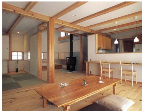
●（現代の住まい） 畳の間と板の間の間の大黒柱。リビング・ダイニングの中心に配置（写真：①）
