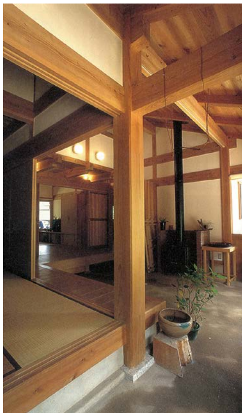
●（現代の住まい） 土間と座敷の間の大黒柱。畳を切り欠かないよう敷居位置をずらしている（写真：①）
