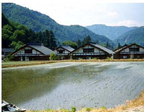
●（楽雪屋根） 雪割棟を設け、金属葺きとして屋根雪を自然に落とす。山並みに調和（富山・楽雪住宅）
