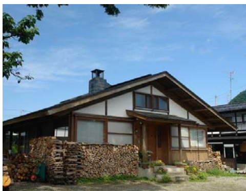
●（深い軒とけらば）軒・けらばを共に外壁から大きく張り出し、外壁を保護し半外部をつくる（写真：⑥）
