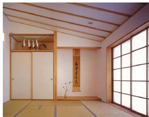
●（現代の住まい） 押入上部の神棚。神棚は壁面から持ち出しが多いが、専用スペースを確保（写真：①）
