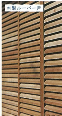
●（多様な格子） 道路に近い場所等視線制御を主に目的として利用できる（写真：①）
