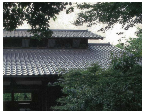
●（いぶし瓦） 経年変化により美しさを増すいぶし瓦（写真：①）
