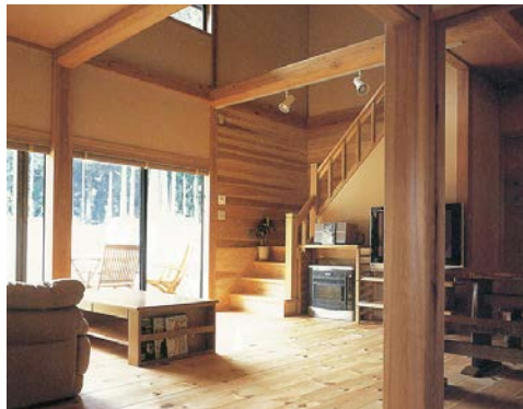
●（現代の住まい2） 板の間における大黒柱。吹抜けと組合せ、視覚的に2階にもつながる（写真：①）
