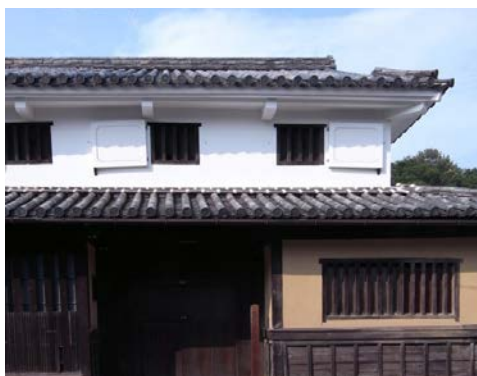
●（伝統的な民家）伝統的な民家の漆喰壁
