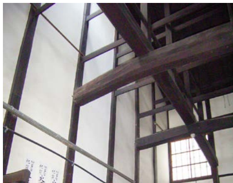
●（京町家） 通り土間の吹抜け。採光と換気の機能を担っている
