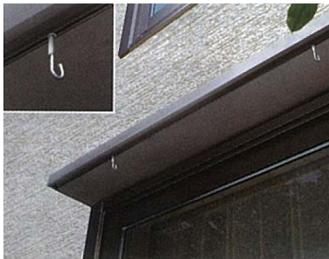
●（ハウスメーカーの事例） 窓底の先端に簾を吊るするためのフックが取り付けられている（写真：②）
