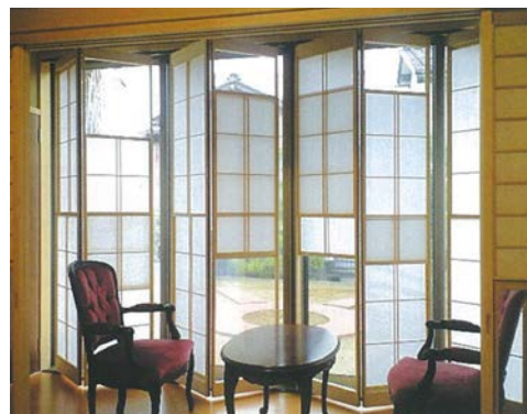
●（新しい取組）障子を用いた折戸の例（写真：①①）
