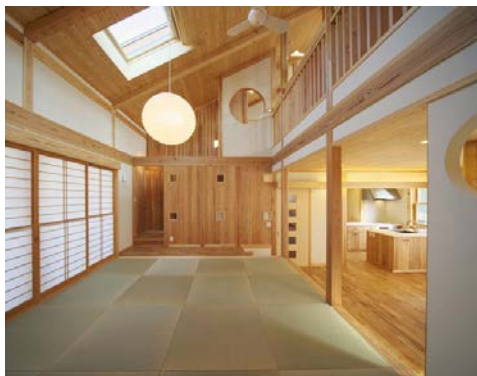
●（漆喰の内観・和室）左官職人の手仕事による風合いのある内部の漆喰壁（写真：⑥）
