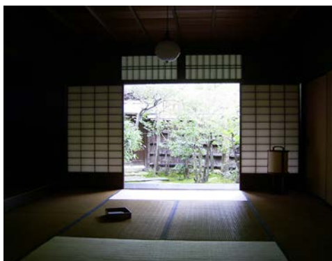
●（伝統的な民家） 屋外と室内の一体性を高める掃き出し窓
