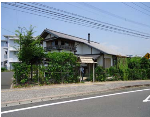
●（まちなみ創出）深い軒による陰影のある美しい外観（熊本・水俣エコハウス）（写真：⑦）
