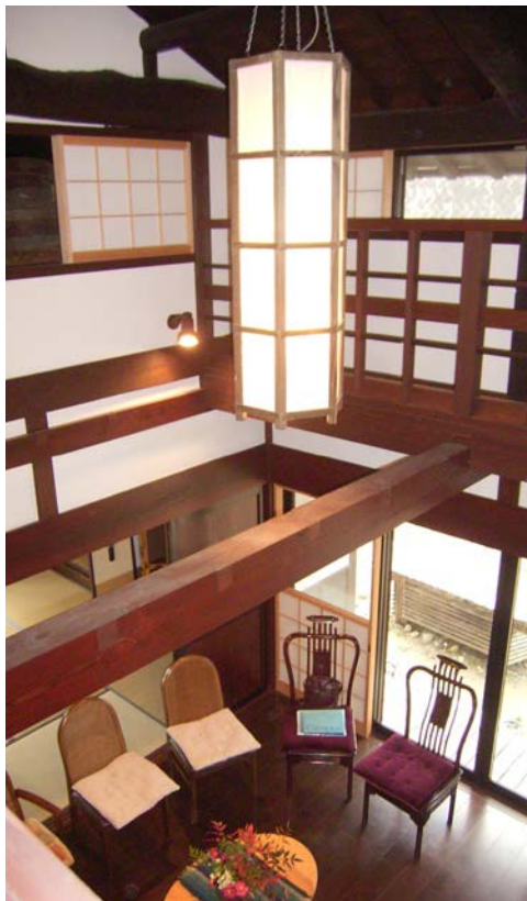
●（現代の住まい） 吹抜け部分の上部が開口となっている例。高窓の効果期待できる
