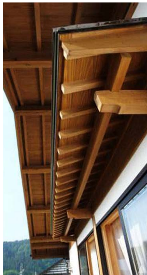
●（現代の住まい） 妻壁の開口部に設けられた窓庇（写真：⑥）
