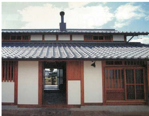
●（越屋根の現代住宅）採光・通風・換気を目的とした越屋根（写真：①）
