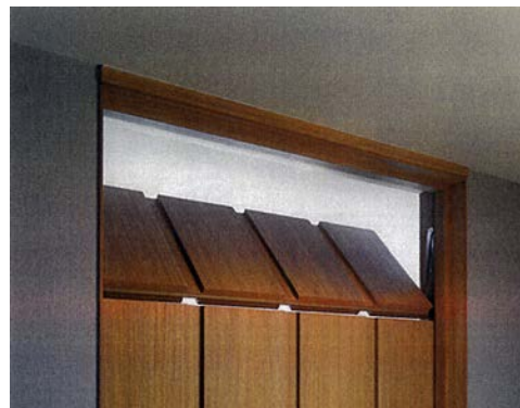
●（ハウスメーカー）天井までの開き戸の上部のみ欄間風に開閉できるようにした例（写真：④）
