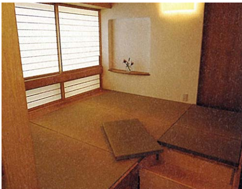
●（下部収納の畳） 下部を収納に利用。畳はオーダーメイドなので自由な大きさがつくれる（写真：①）
