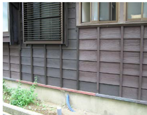
●（板壁の補修）塗装を施すことにより部分的に張り替えた板壁の箇所がほとんど目立たない例
