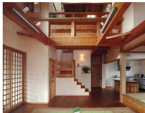
●（現代の住まい） 階段の隔て壁を利用した飾り棚。階段に合わせて段状になっている（写真：①）
