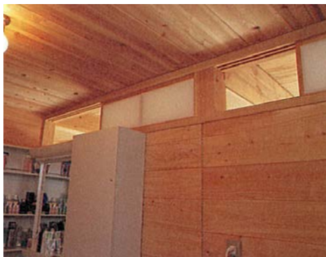
●（現代の住まい）通風を確保するため開閉可能な仕組みを持つ欄間の例（写真：①）
