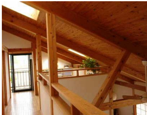
●（現代の住まい） 空気の循環を目的とした小さな吹抜け（写真：⑥）
