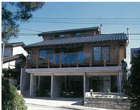
●（越屋根の現代住宅）美しい景観を創出する越屋根（写真：①）
