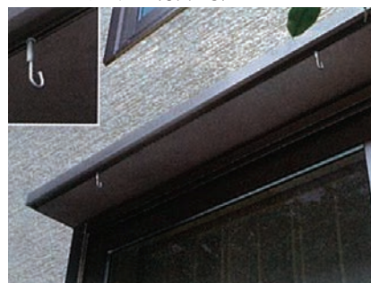
窓庇の先にフック状の金物を取り付け、すだれ等を設けられるようにする (写真:②)
