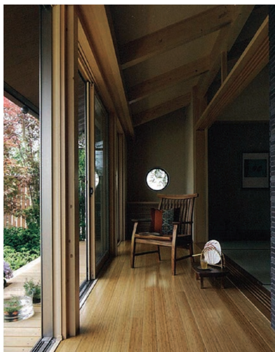
縁側の熱調節機能をも高めるために、縁側と戸外、主室のあいだの建具のつくりを工夫する（写真：④）
