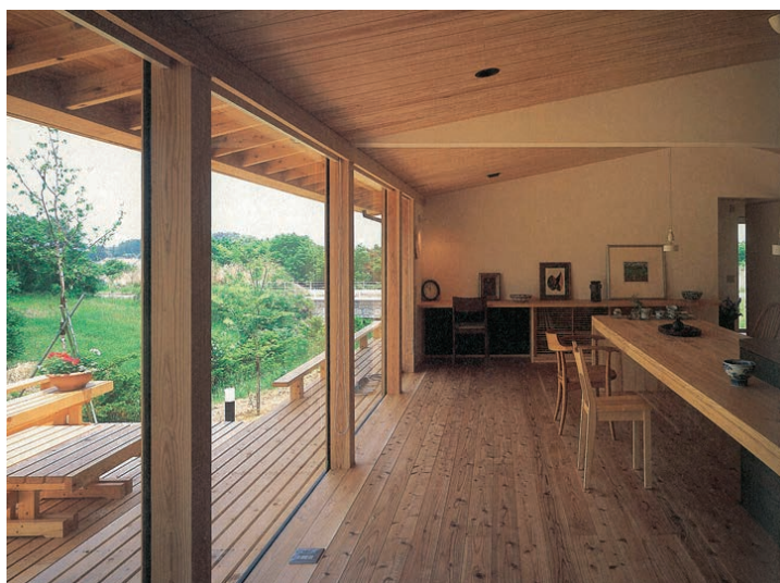
リビングに面する引込み形式の全開放できる掃き出し窓。対面にも窓を設けて室内の風通しをよくする（写真：①）
