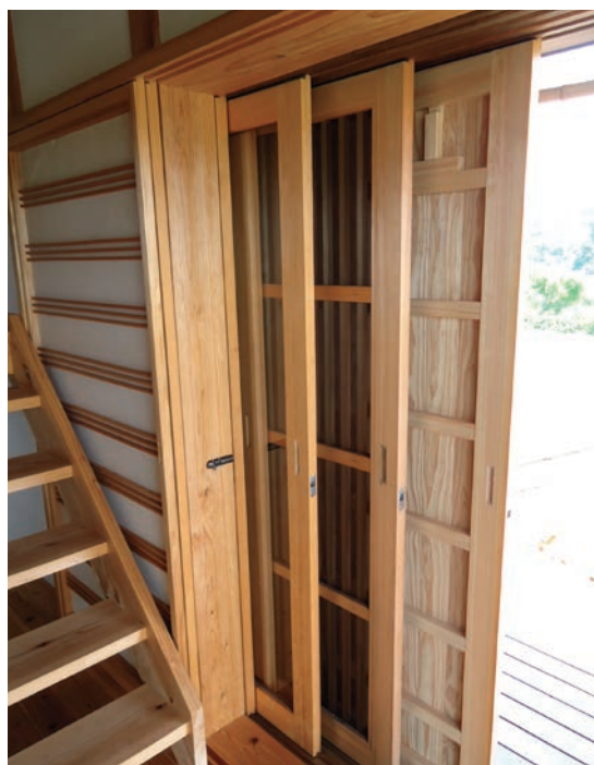
集合住宅の居室とバルコニーのあいだに土間風の中間領域を設け、建具で仕切り熱の移動を調節（写真：①）
