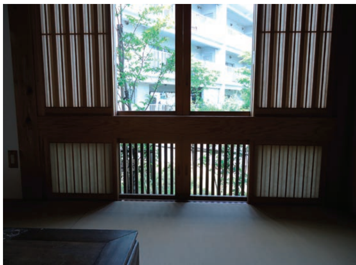
地窓と一般窓を組合せ、地窓には格子を設置。通風、プライバシーの確保とともに防犯や転落防止にも配慮（写真：⑦）
