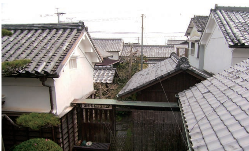
耐久性の高い瓦の勾配屋根。降雨を建物の外に速やかに排水する
