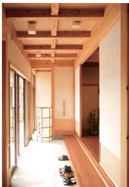
南面の掃き出し窓と窓際の土間。土間床のコンクリート等は蓄熱性が高い
