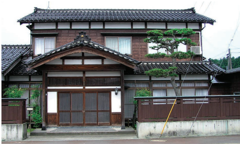
土壁を保護する下見板を付加した外壁。雨掛かりの影響を軽減する
