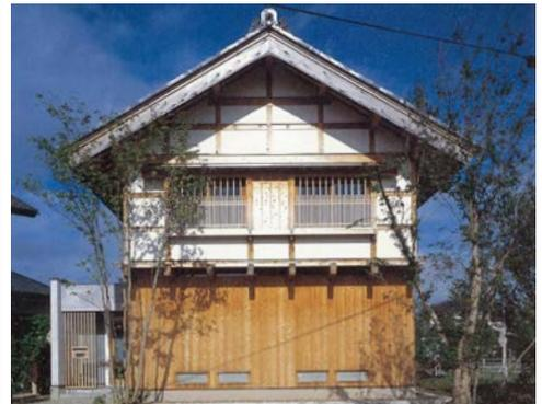
●（腰板張り）外壁の上部は漆喰壁とし、雨掛りの多い腰壁を板張りとする例（写真：①）
