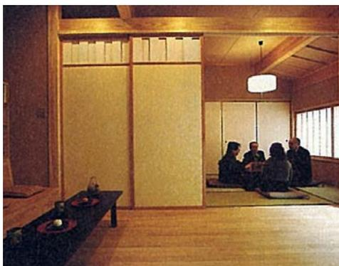
● (現代の住まい) 上部に無双 (2枚の板を左右に移動させて開閉する戸) を組み込んだ建具 (写真: ①)
