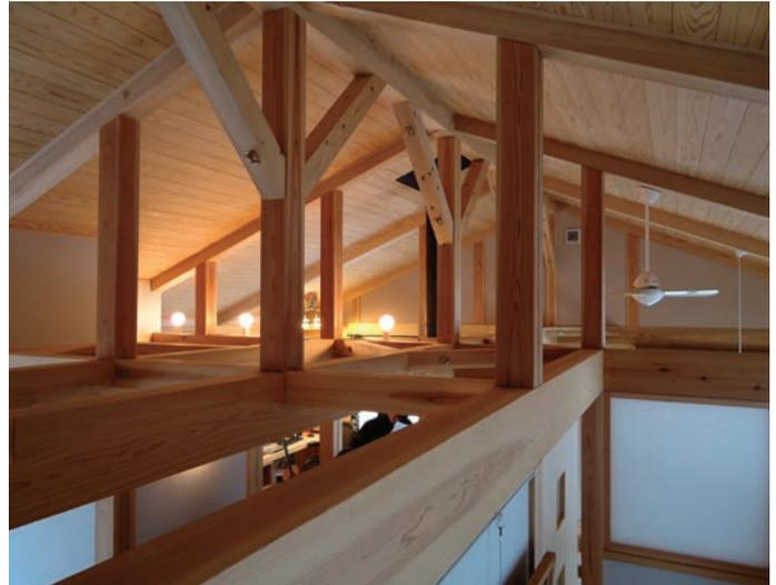
小屋裏現しで天井を高く開放的にし、室内の空気循環をうながす (写真:⑥)
