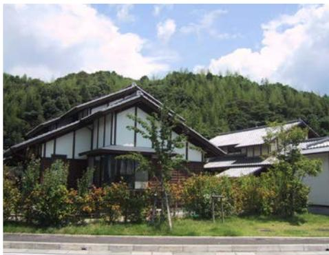
●（雨水の排出）急勾配の屋根は雨水を早期に排出し、屋根の防水性を向上（大分）
