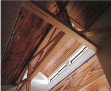
越屋根に設けた開口を開放して、暖められた室内空気を排出する (写真:①)
