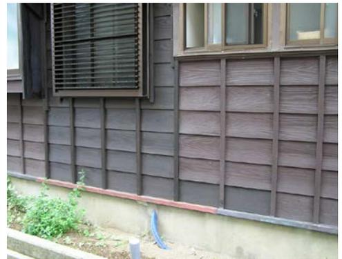
●（板壁の補修）塗装を施すことにより部分的に張り替えた板壁の箇所がほとんど目立たない例
