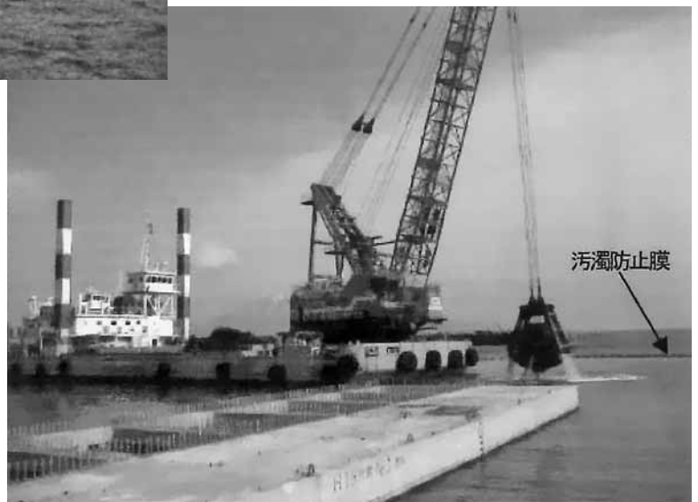
漁場へ配慮した施工
