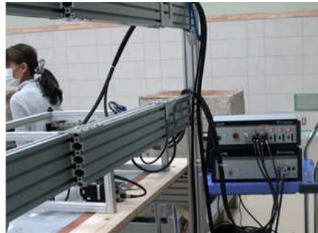
図9 制御システム部の配置(ワゴン上)
