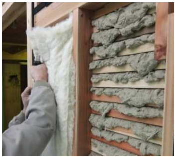
○ 土壁で外断熱とした施工のイメージ
