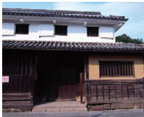
伝統的な民家の漆喰壁
