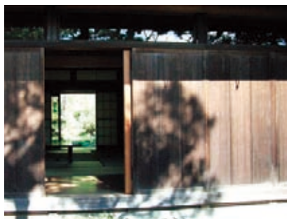
伝統的な民家の雨戸。風雨から開口部を守る戸であるが、防犯、遮音、断熱の機能をもち得る
