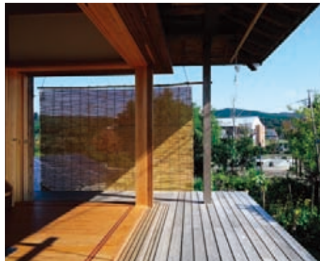
軒先に吊るされたすだれ。軒先から少し内側に設けたほうが耐久性は向上する（写真：⑦）
