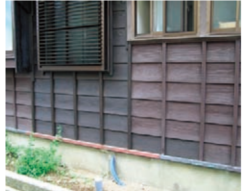
板壁を部分的に張り替えた後に塗装を施す。補修箇所が目立たず全体が馴染む（新潟・和島）
