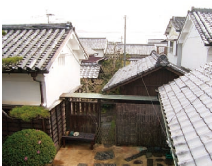
耐久性の高い瓦の勾配屋根。降雨を建物の外に速やかに排水する
