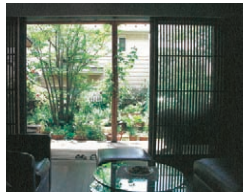
格子戸を締め切ると、風を通しつつ中からは見え、外からは見えない。まぶしさも緩和（写真：①）
