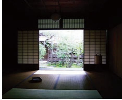
伝統的な民家における屋外と室内の一体性を高める掃き出し窓
