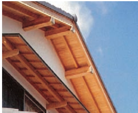
妻壁の開口部に設けられた窓庇（写真：①）
