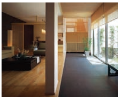
南面の連続する掃き出し窓と窓際の土間。大きな開口は太陽熱を取得する効果が高い（写真：②）
