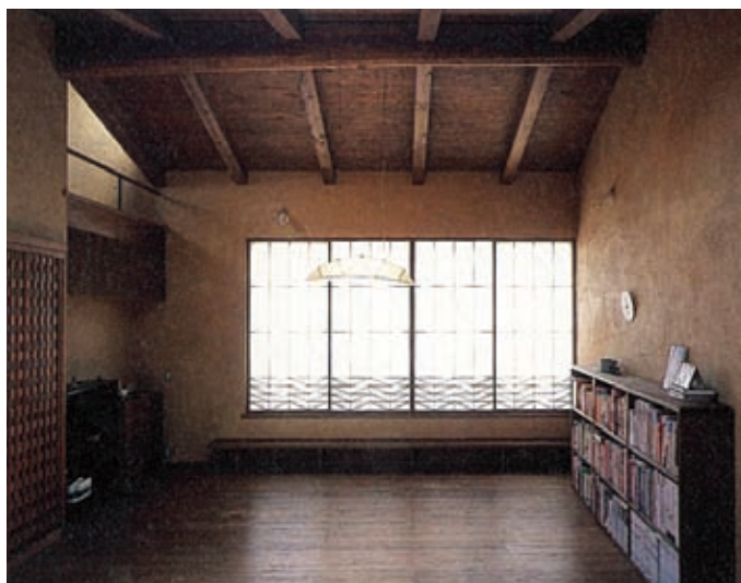
土壁や漆喰塗り仕上げの壁装。風合いがよいことに加え、土壁は蓄熱にも効果がある（写真：①）
