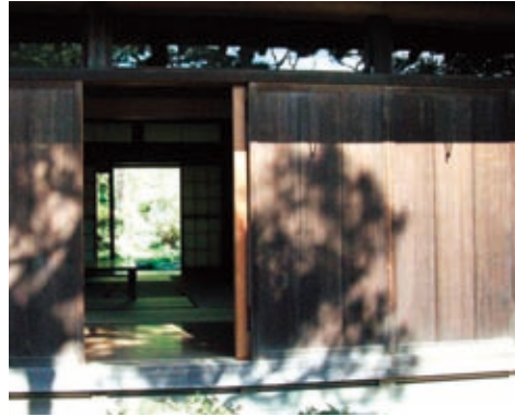
伝統的な民家における板戸の雨戸
