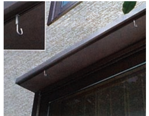
窓庇の先端に、すだれを吊るするためのフックが取り付けられている（写真：②）
