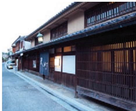
伝統的な京町家で通りからの視線制御を主に意識している
