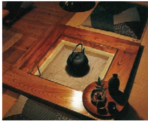
周縁部にものを置ける板をまわした囲炉裏 (写真: ①)
