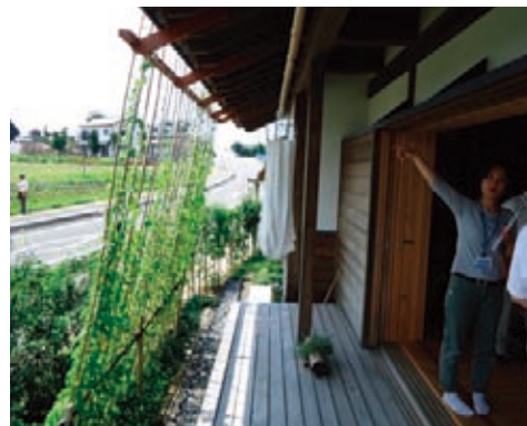
日射遮蔽のためのよしずの役割を担う、つる性植物による緑のカーテン (写真: ⑦)
