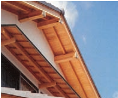
妻壁の窓に付属する窓庇。開口部を雨から守るとともに、日射遮蔽の機能ももつ（写真：①）
