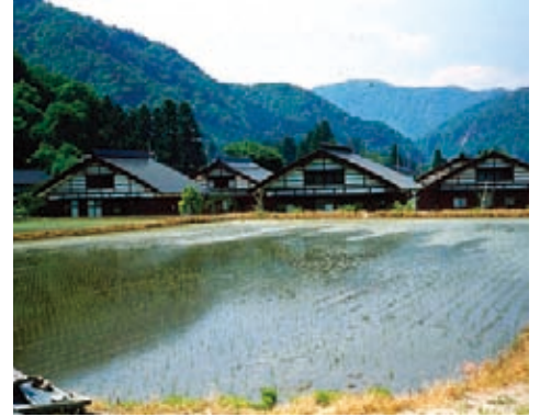
雪割棟を設け、金属葺きとして屋根雪を自然に落とす。山並みに調和(富山)
