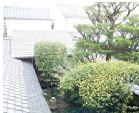
町家の坪庭の配置を近隣と協調することで、採光や通風を確保し合う
