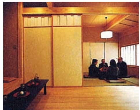
室内の通風のために上部に無双（2枚の板を左右に移動させて開閉する戸）を組み込んだ内部建具（写真：①）
