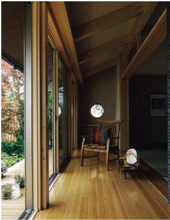
縁側は部屋と屋外の緩衝空間となり、熱の移動を調節する (写真: ②)
