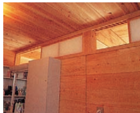
通風を確保するため開閉機能を持つ欄間（写真：①）
