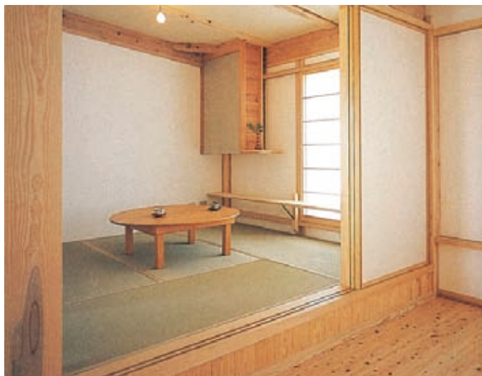
畳、漆喰塗などの自然素材を利用し、吸放湿性を高める (写真：①)
