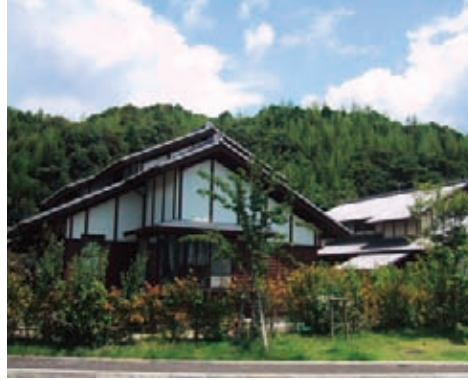
勾配屋根は雨水を早期に排水し、屋根の防水性を向上(大分)
