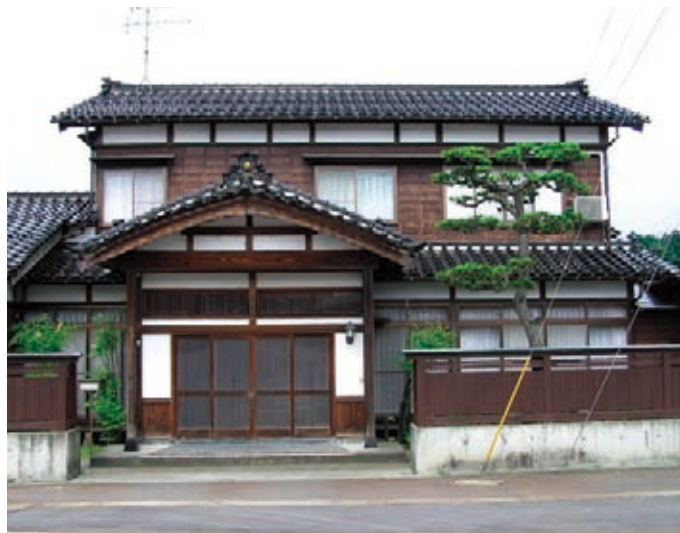
土壁を保護する下見板を付加した外壁。雨掛かりの影響を軽減する
