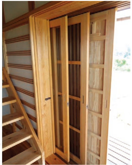
外から雨戸、網戸、ガラス戸と障子を複合。季節や気候特性に応じて様々な建具を組み合わせることが大切 (写真: ⑦)
