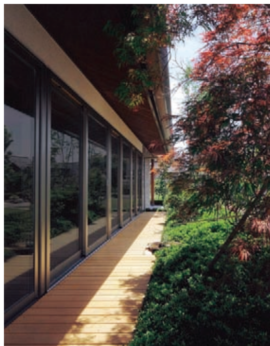
軒庇による日射遮蔽。太陽高度の高い南面では単独で使える手法 (写真：②)
