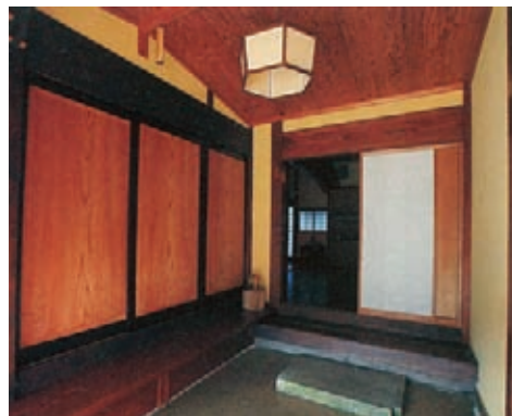
伝統的な民家における間仕切り板戸の引戸（写真：①）
