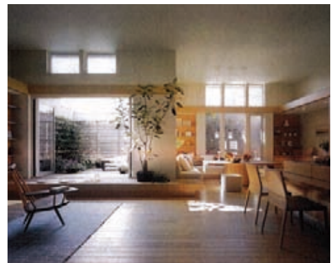
通常の天井高さで内法の上部分が開口となっている高窓の例（写真：④）
