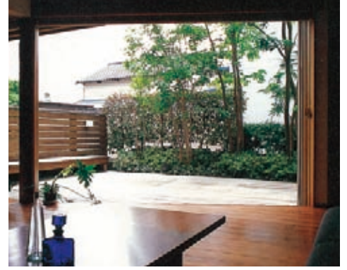
引込み形式の掃き出し窓を全面開放して、リビングと外部デッキ・庭との連続性を高める（写真：①）
