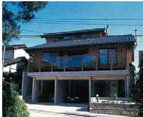
美しい景観を創出する越屋根(写真:①)
