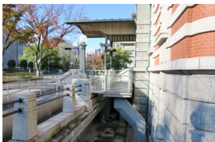
上：ドライエリアを利用した スロープの設置 下：正面入口スロープと点字 ブロック
