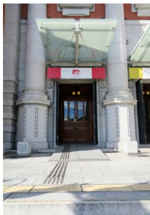
上：ドライエリアを利用した スロープの設置 下：正面入口スロープと点字 ブロック
