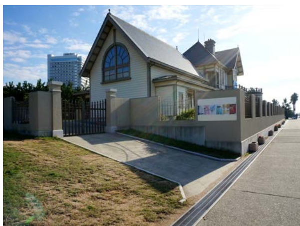
敷地入口 スロープ
