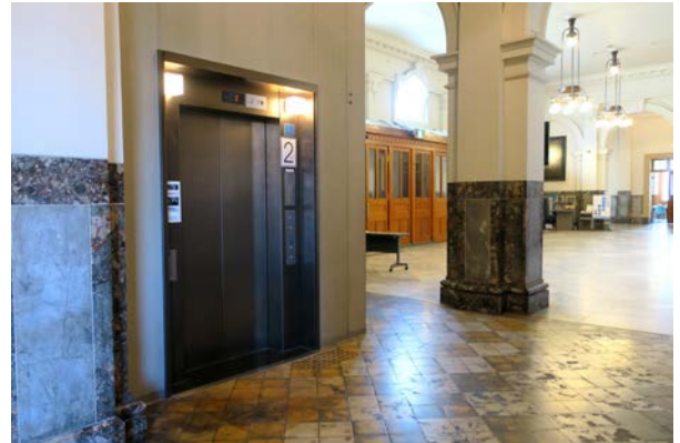
玄関ホールエレベーター
