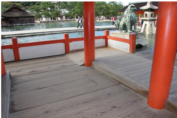
本社祓殿と平舞台との間の段差解消用スロープ
