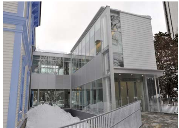
附属棟メインエントランス前スロープ
