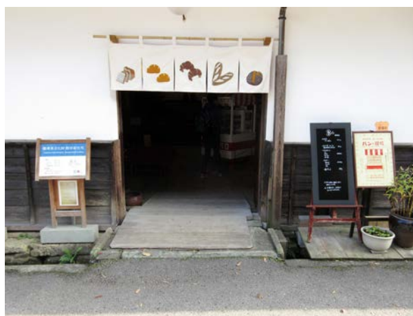
重要文化財熊谷家住宅入口スロープ
