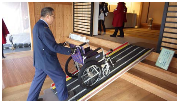
箱館奉行所玄関の着脱式スロープ
