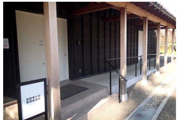
管理事務所入口スロープ
