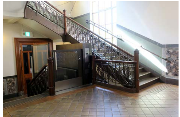
吹き抜けを利用した段差昇降機
