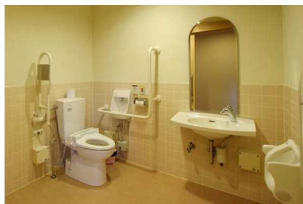
新築された多機能トイレ
