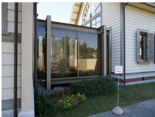
管理棟を繋ぐ渡り廊下
