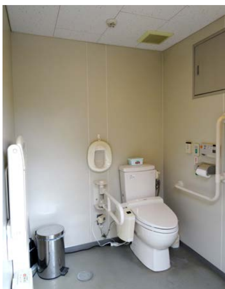
左：2階食堂への階段に取り 付けられた補助手摺 右：ショップに隣接する多機 能トイレ
