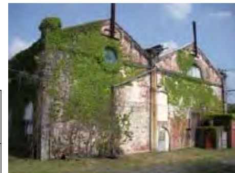
↑ 遠賀川水源地ポンプ室 (福岡県中間市)
