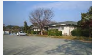
整備箇所の現状
