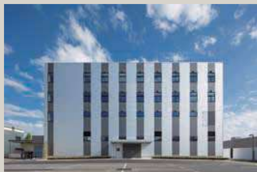
▲ メカトロサポートセンタ 所在地：名古屋市東区（本社敷地内）
