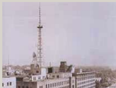
▲ 加藤電気工業所の原点。昭和 28 年 2 月 1 日に、我が国初のテレビジョン放送を開始したときの 6 段同軸開放型アンテナ（当社製） 「千代田区・内幸町の NHK 放送会館屋上」
