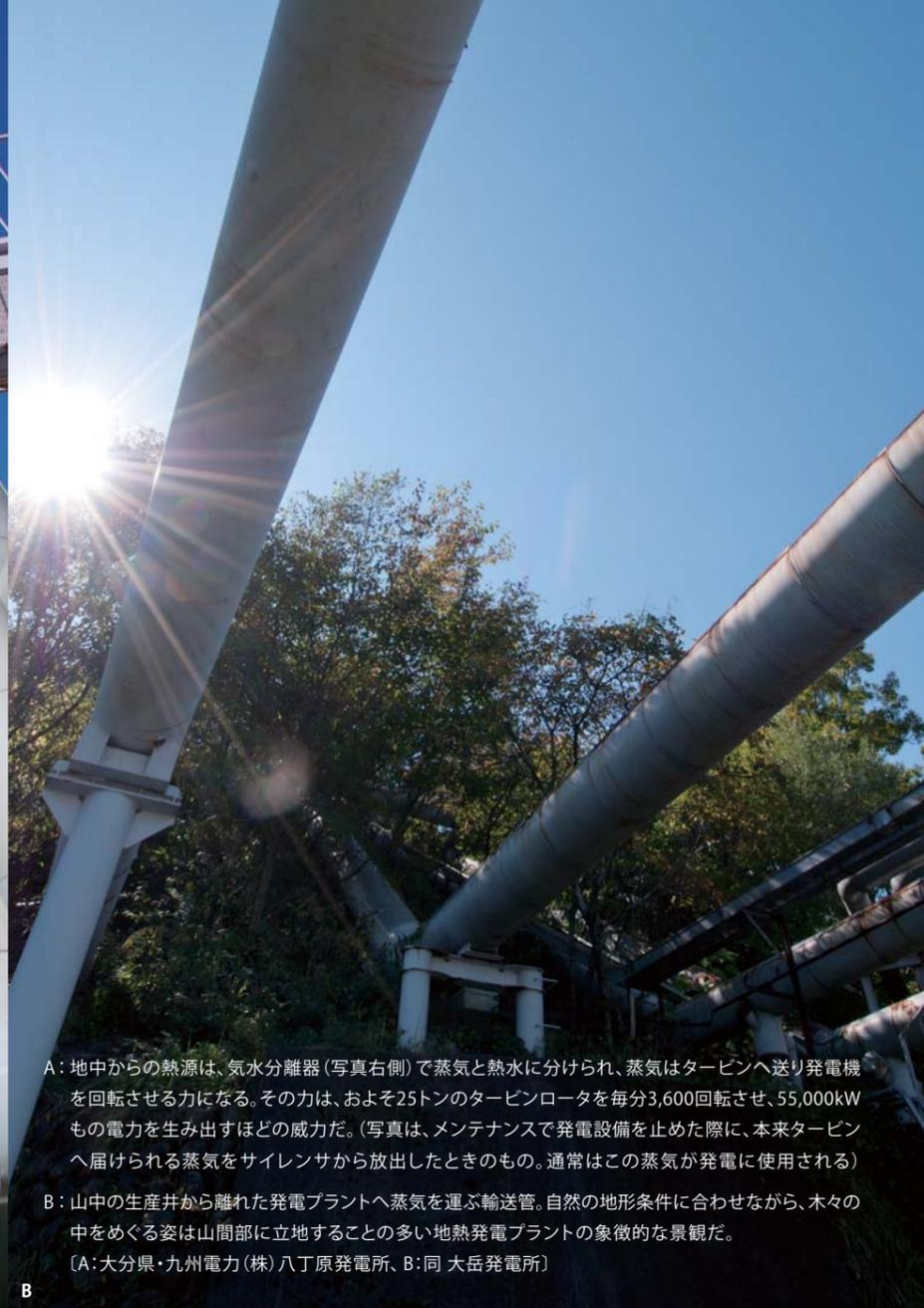
A: 地中からの熱源は、気水分離器(写真右側)で蒸気と熱水に分けられ、蒸気はタービンへ送り発電機を回転させる力になる。その力は、およそ25トンのタービンロータを毎分3,600回転させ、55,000kWもの電力を生み出すほどの威力だ。(写真は、メンテナンスで発電設備を止めた際に、本来タービンへ届けられる蒸気をサイレンサから放出したときのもの。通常はこの蒸気が発電に使用される)
