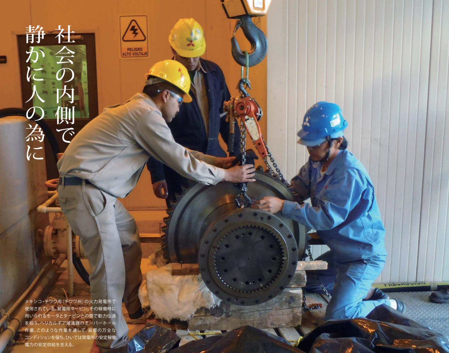
メキシコ・チワワ市(チワワ州)の火力発電所で使用されている、発電用タービン。その稼働時に用いられるモータとタービンとの間で動力伝達を担う、ヘリカルギア減速機のオーバーホール作業。このような作業を通して、装置の万全なコンディションを保ち、ひいては発電所の安定稼働、電力の安定供給を支える。
