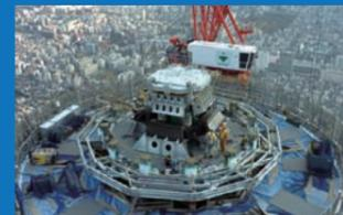
東京スカイツリー®の建設中に、地上497mの塔体頂部に仮置きされた「制振装置」。写真提供:大林組
