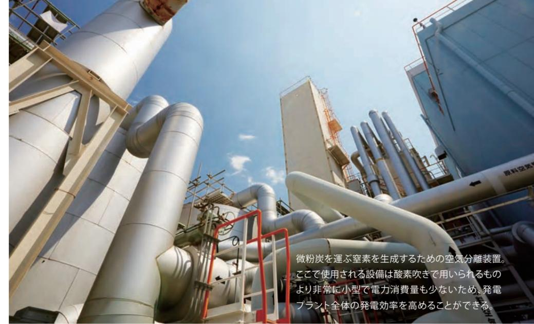
微粉炭を運ぶ窒素を生成するための空気分離装置。ここで使用される設備は酸素吹きで用いられるものより非常に小型で電力消費量も少ないため、発電プラント全体の発電効率を高めることができる。
