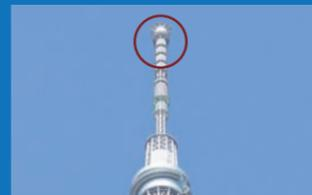
「制振装置」は、放送用アンテナを支えるゲイン塔の最先端部に設置されている。
