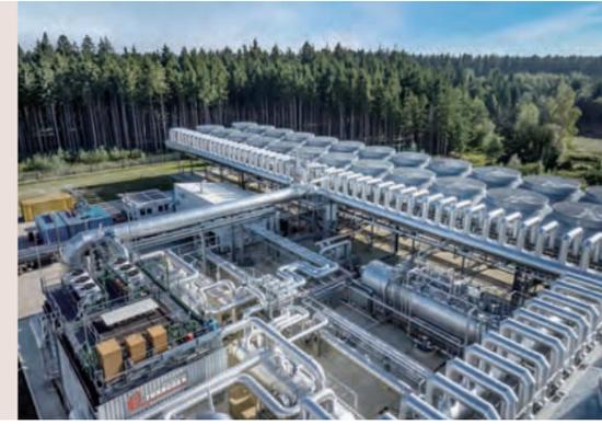
従来型より出力約20%増を実現した「ダブルフラッシュ方式」。フラッシュャーにより、熱水を蒸気に変えて発電に使用することで、より高効率に!!
