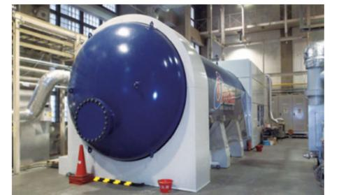
2008年から三菱重工・長崎造船所で開発を進めてきた、固体酸化物形燃料電池(SOFC)とマイクロガスタービン(MGT)を組み合わせた200kW級の加圧型ハイブリッドシステム。同システムは世界初となる4,000時間超の連続運転を達成し、省エネ・高効率の発電を実証した。今後は、安全性検証試験を実施し、市場開拓へとつなげていく。
