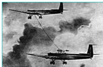
Метод передачи горючего в полёте по предложению П.И. Гроховского
