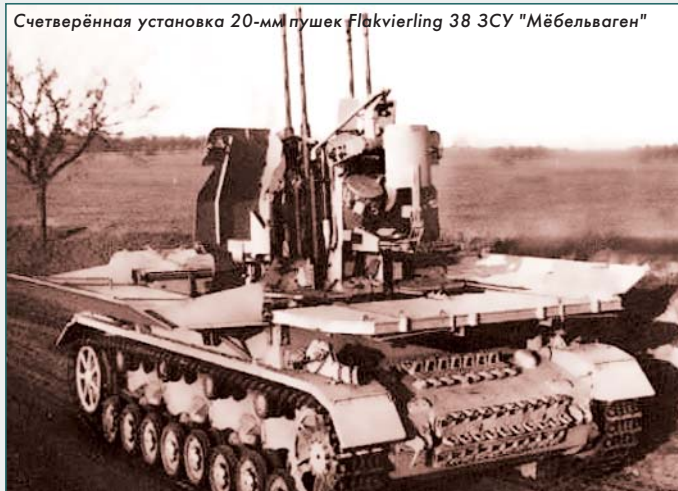
Счетверённая установка 20-мм пушек Flakvierling 38 ЗСУ "Мёбельваген"
