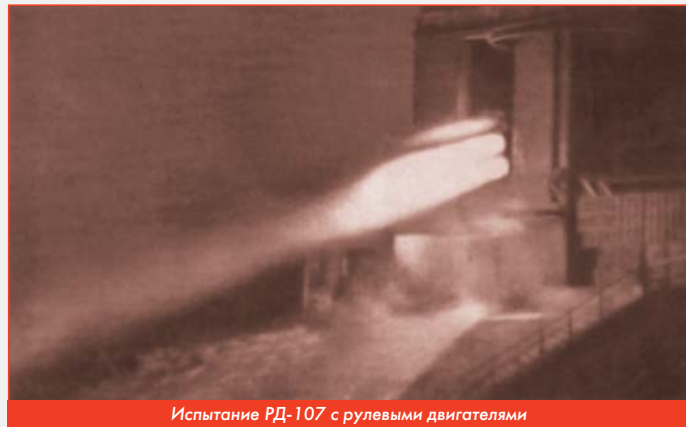
Испытание РД-107 с рулевыми двигателями
