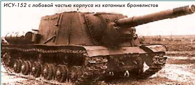
ИСУ-152 с лобовой частью корпуса из катаных бронелистов
