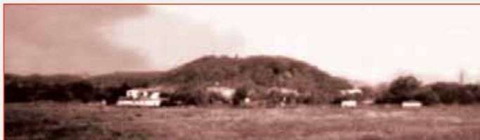
Панорама подземного завода "Миттельверке" в районе г. Нордхаузен
