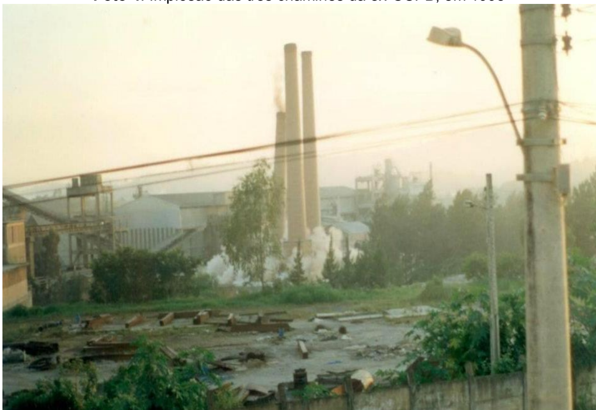
Foto 4. Implosão das três chaminés da ex-CCPB, em 1998
