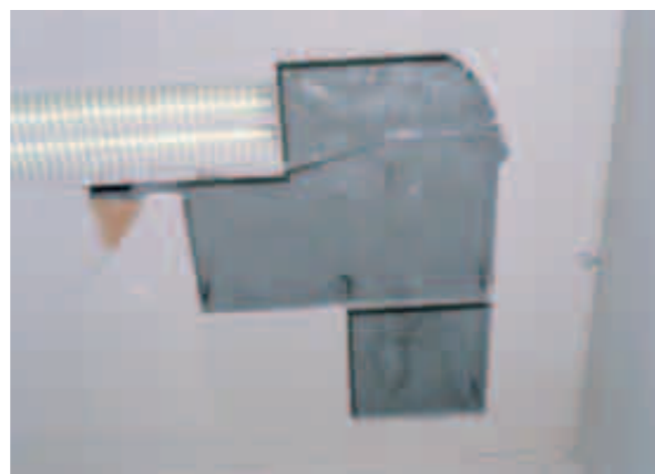
図3 爆発の影響が天井(5m)まで到達した痕跡
