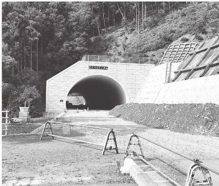
工事中の南島バイパス
