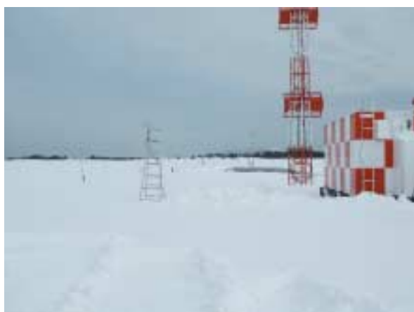
【 積雪時の青森空港グライドパス・アンテナの周辺風景 】
