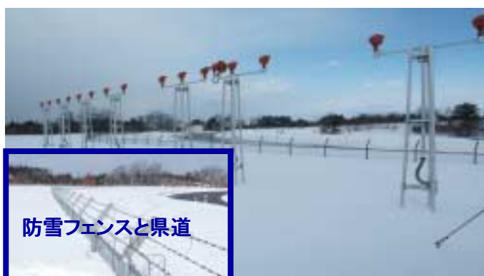
【 電波高度計用地の積雪状況と防雪フェンス 】
