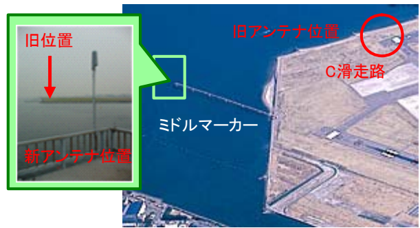
図3 移設後のRU3アンテナの設置状況
